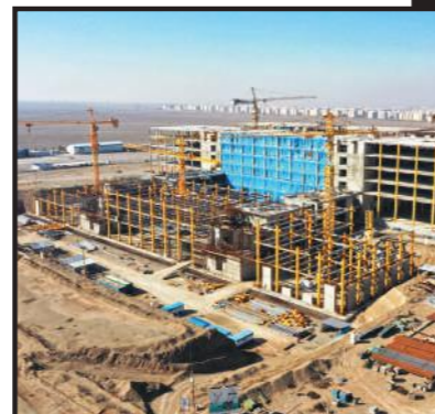
اسکلت فلزی سازه بلوک C بیمارستان خاتم قم
