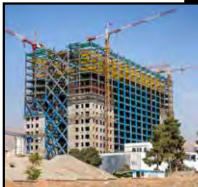
..... [اسکلت سازه فلزی بیمارستان سلامت برکت]
